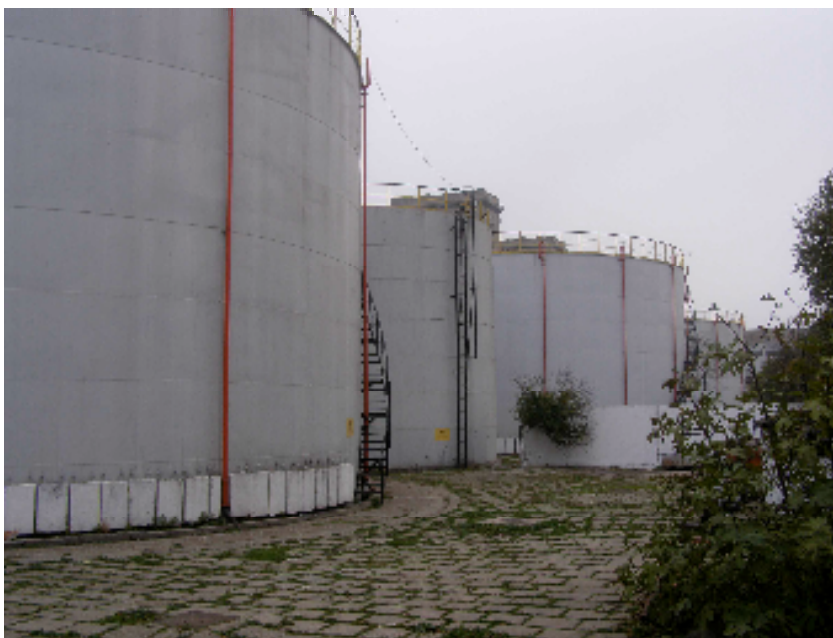
Foto: cele 4 rezervoare pentru ulei vegetal , total 12.000t
