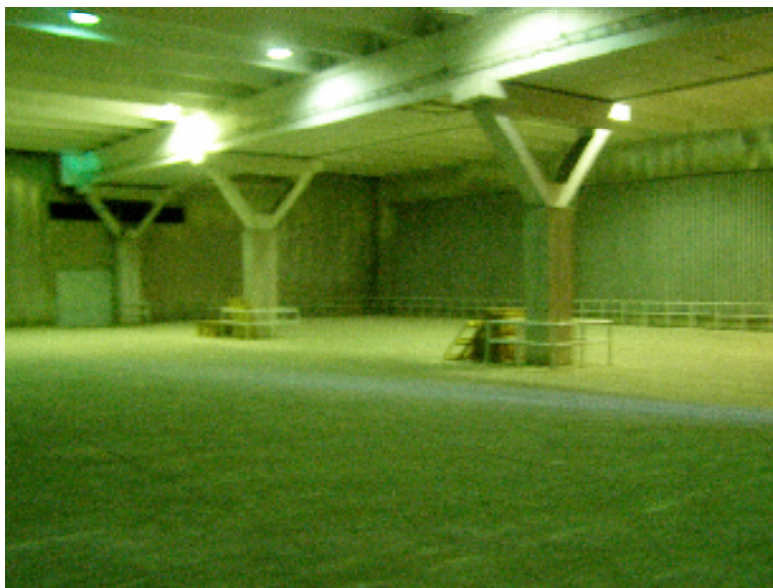
Foto: Interior depozit frigorific Dana 53
